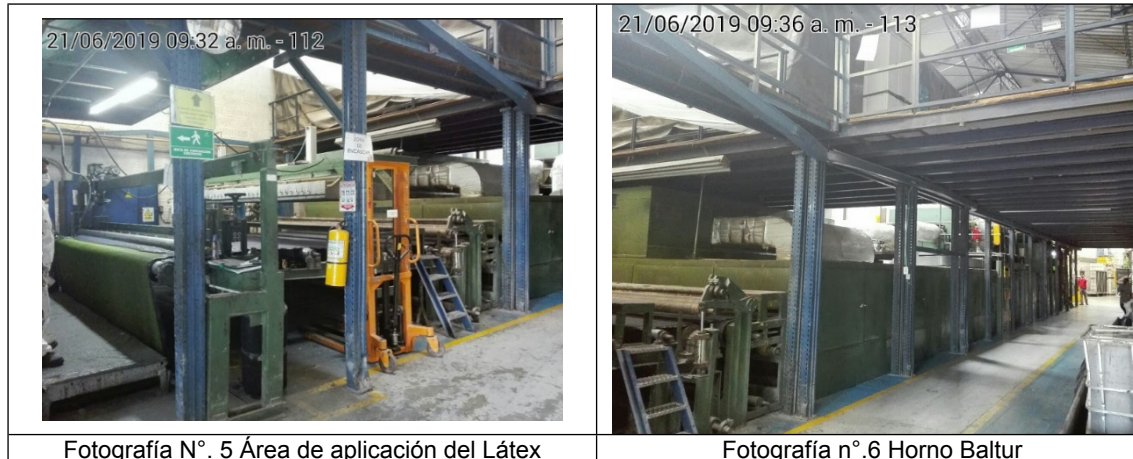
Fotografía N°. 5 Área de aplicación del Látex
